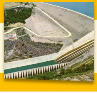
Kütahya 2MW Eger HES AG-OG Elektrik İşleri
