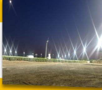
Antalya Gece Koşusu Aydınlatma Kablo Çekimi Trafo Montaj İşleri
