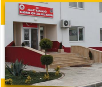
Bandırma Açık Ceza İnfaz Kurumu Elektrik- Elektronik İşleri ve TM Kurulumu
