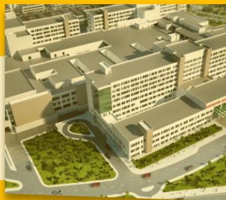
Eskişehir Şehir Hastanesi C blok ve YGAP blok Elektromekanik İşleri
