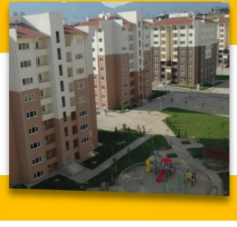
Uzundere TOKİ 1200 Konut Elektrik-Elektronik İşleri
