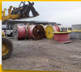
Balıkesir Biyogaz Santrali Enerji Nakil Hattı Yeraltı Kablosu İşi
