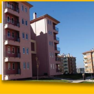
Denizli Umutkent 800 Konut Elektrik İşleri
