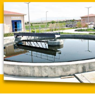
Ayaş Atık Su Arıtma Tesisinin AG-OG ve Otomasyon İşleri
