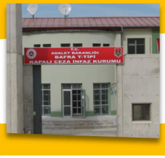
Bafra Kapalı Ceza İnfaz Kurumu Elektrik-Elektronik Sistemler ve Bina Tipi TM Kurulumu
