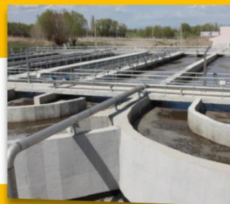
Kazan Atık Su Arıtma Tesisinin AG-OG ve Otomasyon İşleri
