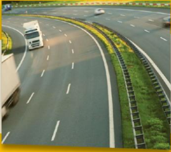
İzmir-Aydın-Çeşme Otoyolu Aydınlatma İşleri
