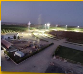
Diyarbakır Gece Koşusu Aydınlatma Direkleri Dikimi ve Kablo Çekimleri Trafo Montajı
